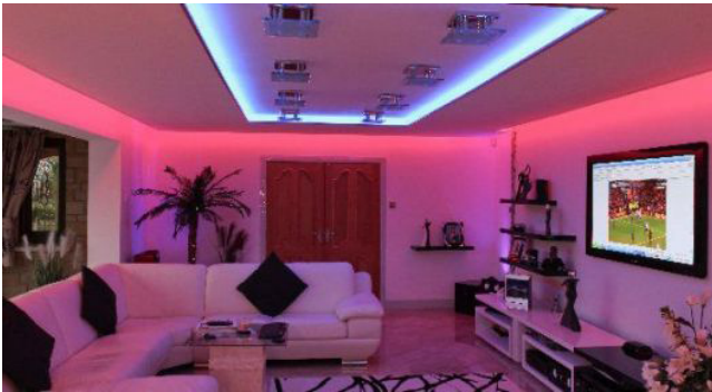
Figura 47. Fitas de led RGB atuando como iluminação complementar em um ambiente. Fonte: Doce Obra (2020).
