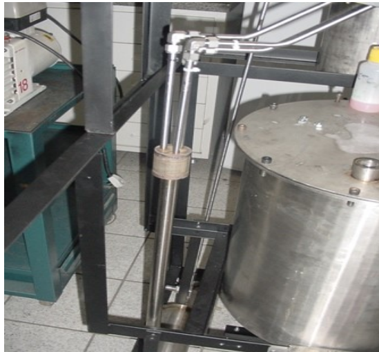
Figura 29: Tubulações de vapor do termossifão da unidade em aço
