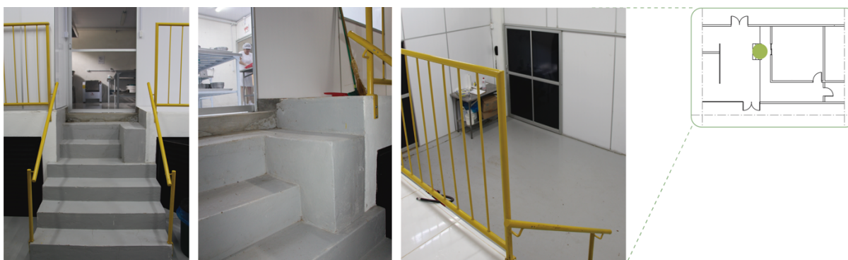
Figura 60: escada próxima a saída da cozinha.
