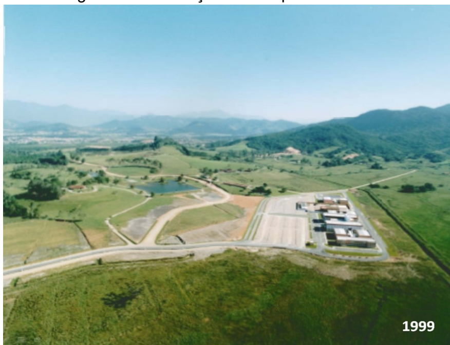
Figura 16 - Instalação do campus da UNISUL
