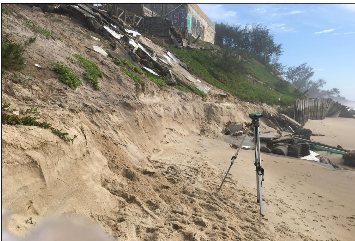
Figura 42. Vista para norte do P5 na praia do Campeche, setor Sul da área de estudo, demonstrando o início do processo de escarpamento devido à erosão costeira (Fonte: o autor, novembro de 2018).
