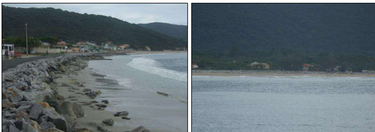
Figura 220: Vista geral do enrocamento construído na praia da Armação e que constitui o Depósito tecnogênico espólico do setor Sudeste da ISC.
