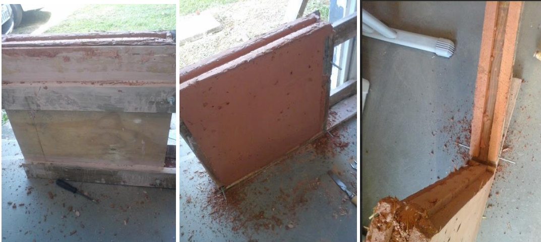
Painel sendo desenformado
