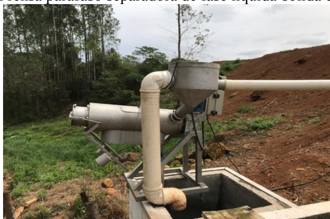
Figura 4 - Prensa parafuso separadora de fase líquida-sólida de digestato.
