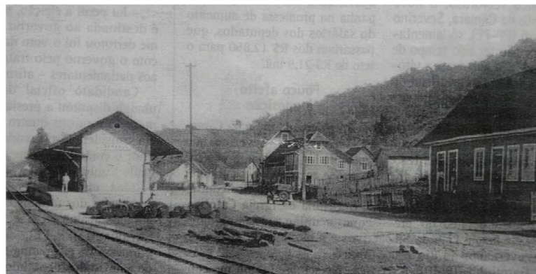
Estação Ferroviária - Bananal, 1930
