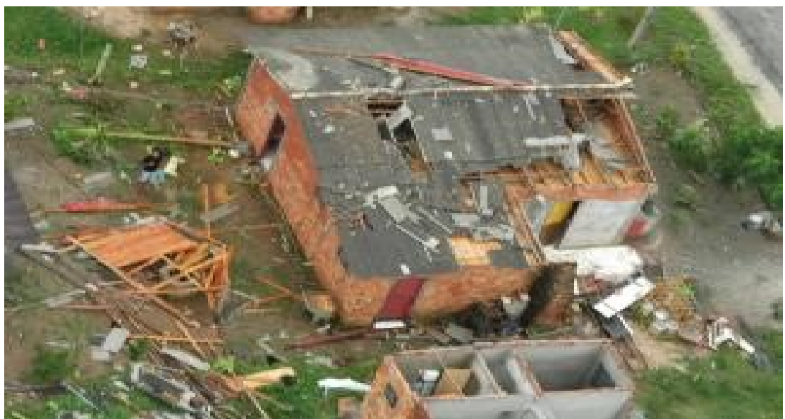
Figura 19: Destruição no sul de SC após o furacão Catarina em 2004. Fonte: Defesa Civil de SC. 2008
