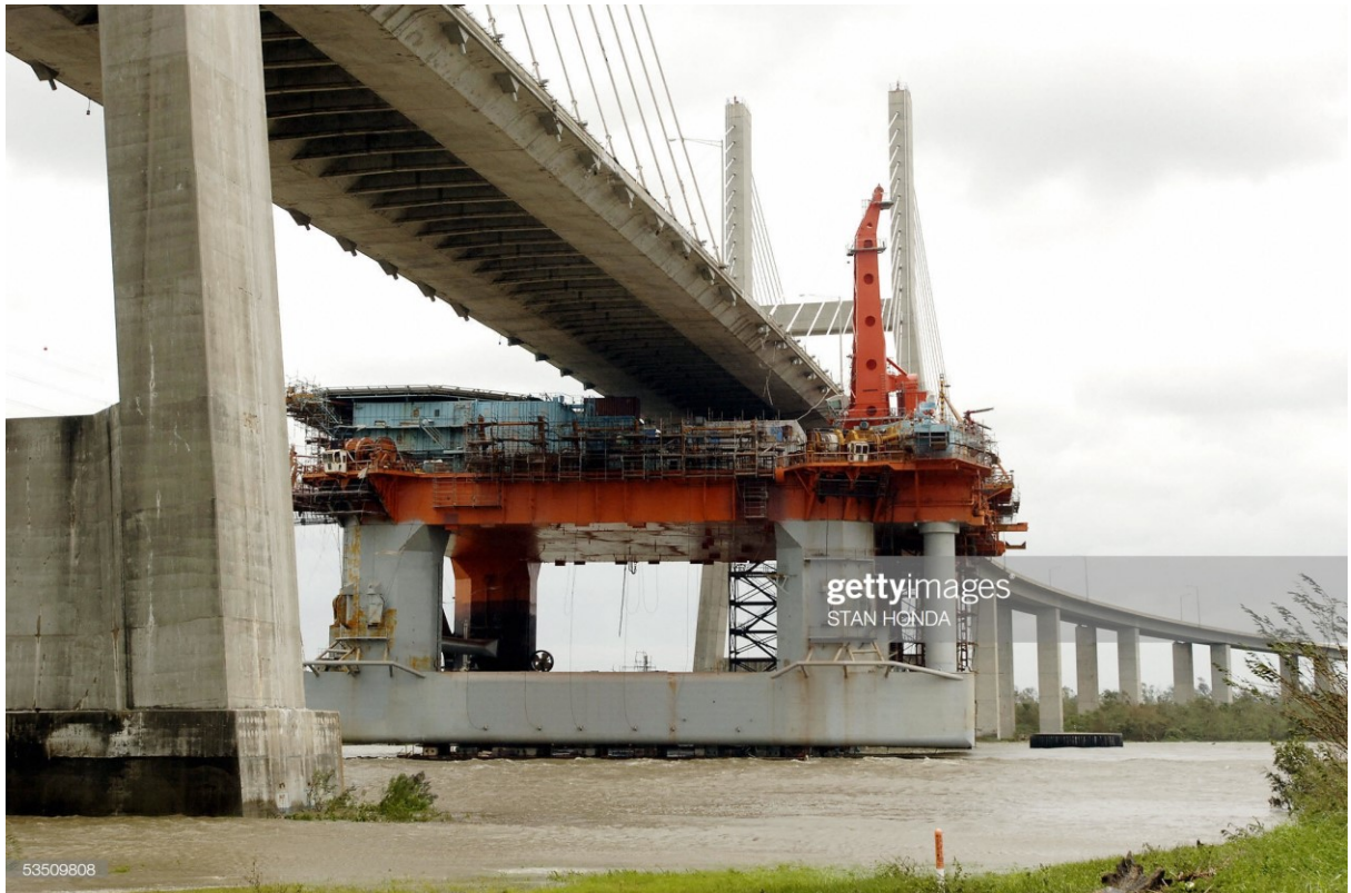
Figura 15: Plataforma de petróleo arrastada pelo furacão Katrina (2005). Fonte: Gettyimages
