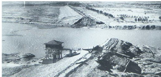
Destruição causada pelo tufão Nina em 1975.
