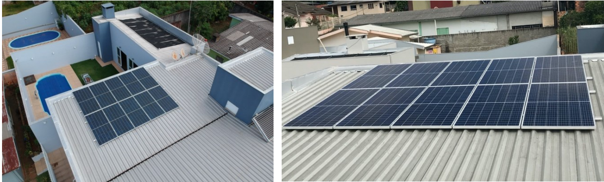
Figura 13 – Vista do local de instalação dos módulos fotovoltaicos na Unidade X.
