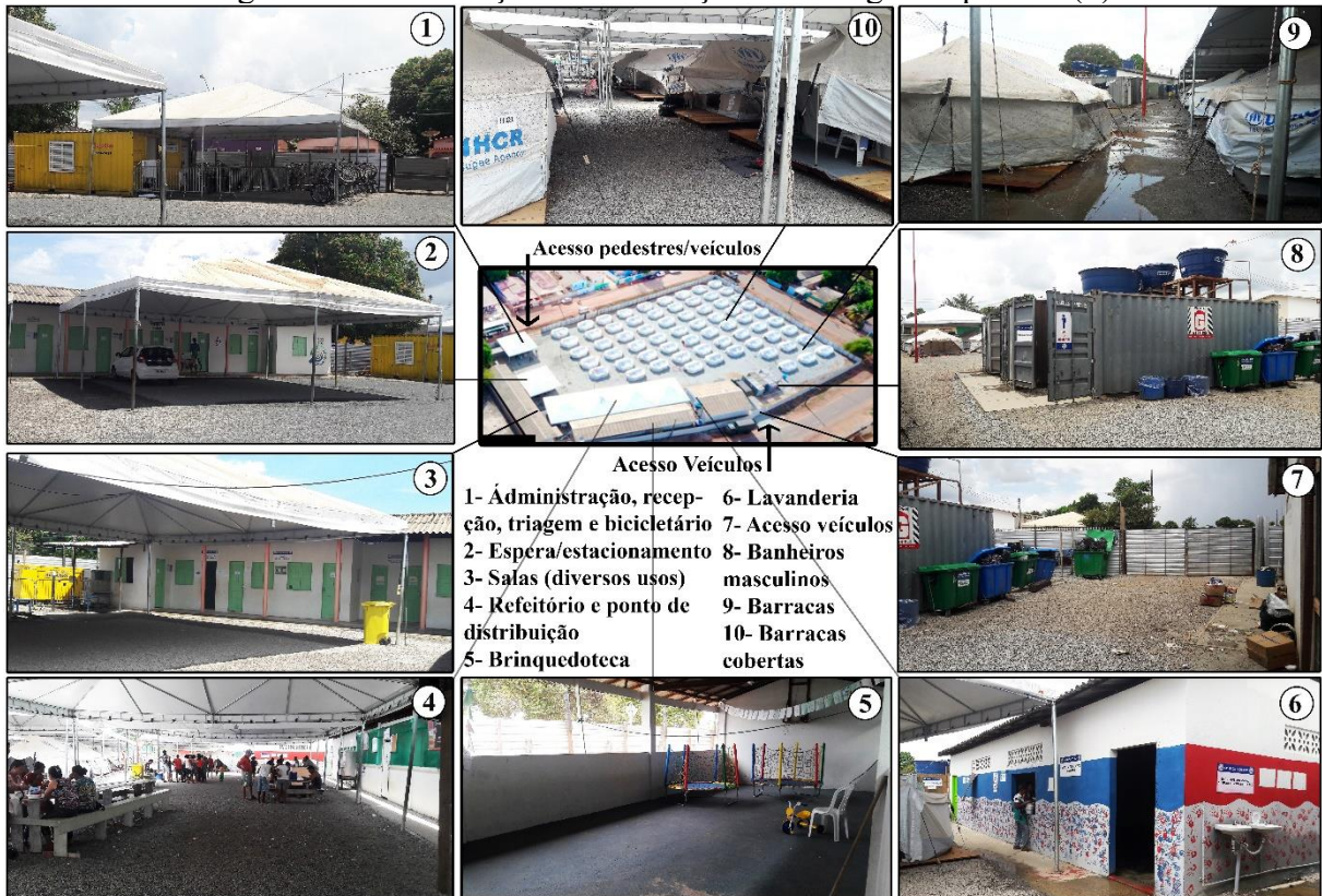
Figura 33 - Localização das instalações no abrigo temporário (1).
