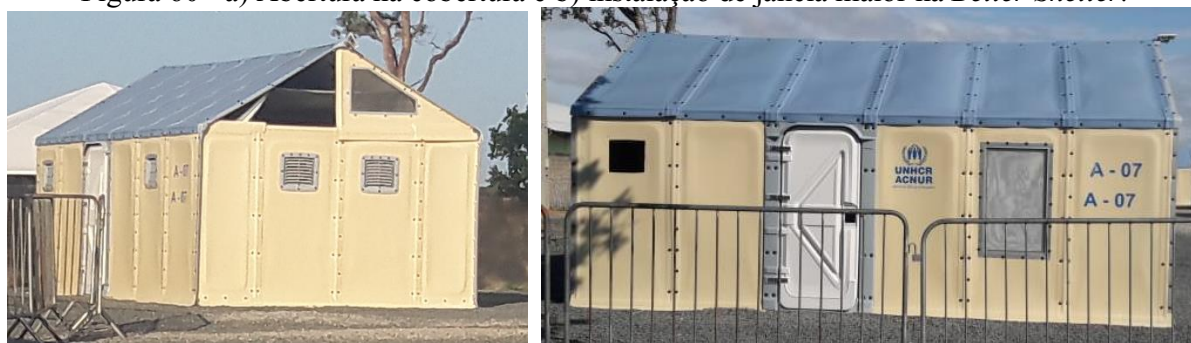
Figura 60 - a) Abertura na cobertura e b) instalação de janela maior na Better Shelter .
