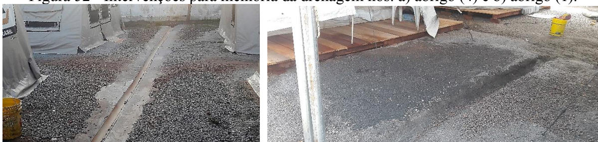
Figura 52 - Intervenções para melhoria da drenagem nos: a) abrigo (4) e b) abrigo (1).
