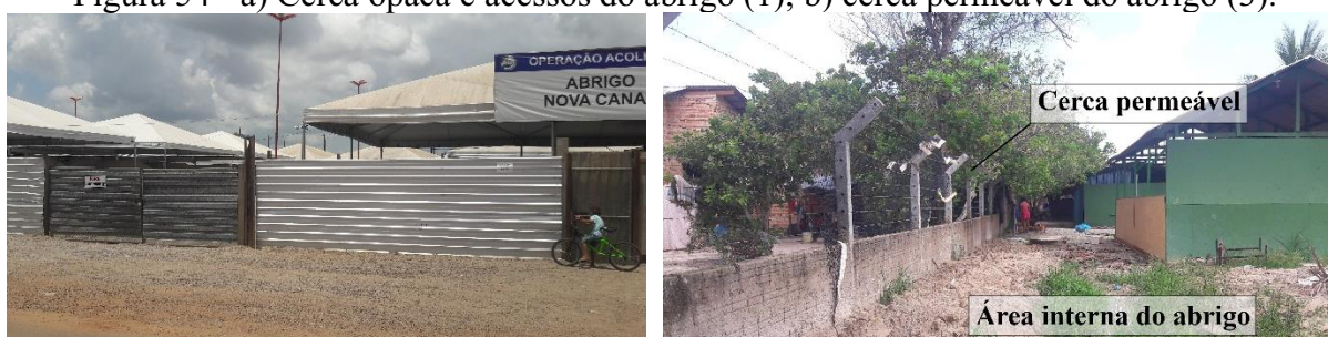
Figura 54 - a) Cerca opaca e acessos do abrigo (1); b) cerca permeável do abrigo (3).
