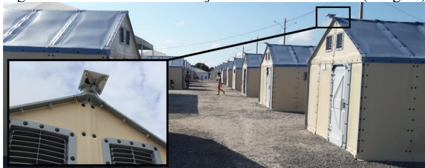
Figura 49 - Painel solar nos alojamentos Better Shelter (abrigo 6).
