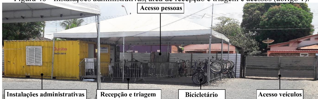
Figura 40 - Instalações administrativas, área de recepção e triagem e acessos (abrigo 1).
