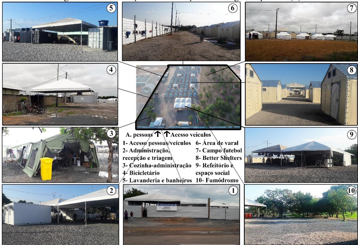
Figura 38 - Localização das instalações no abrigo temporário (6).
