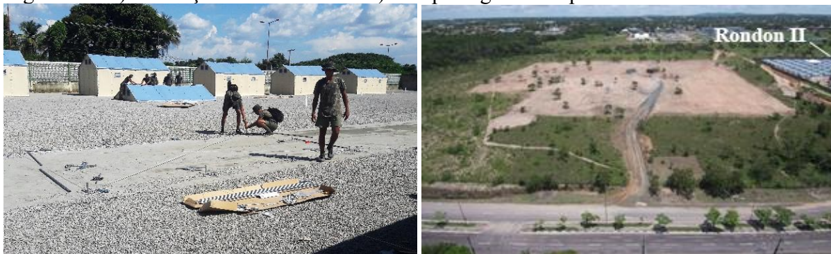
Figura 28 - a) Instalação do Rondon II e b) terraplanagem e limpeza do terreno do Rondon III.
