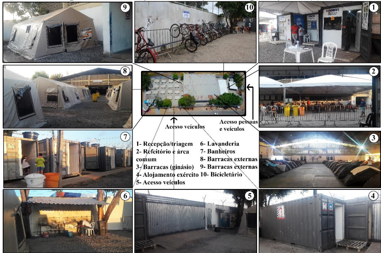
Figura 36 - Localização das instalações no abrigo temporário (4).
