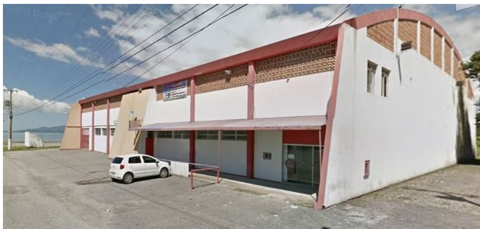
Figura 36 - Ginásio de Esportes demolido em 2019
