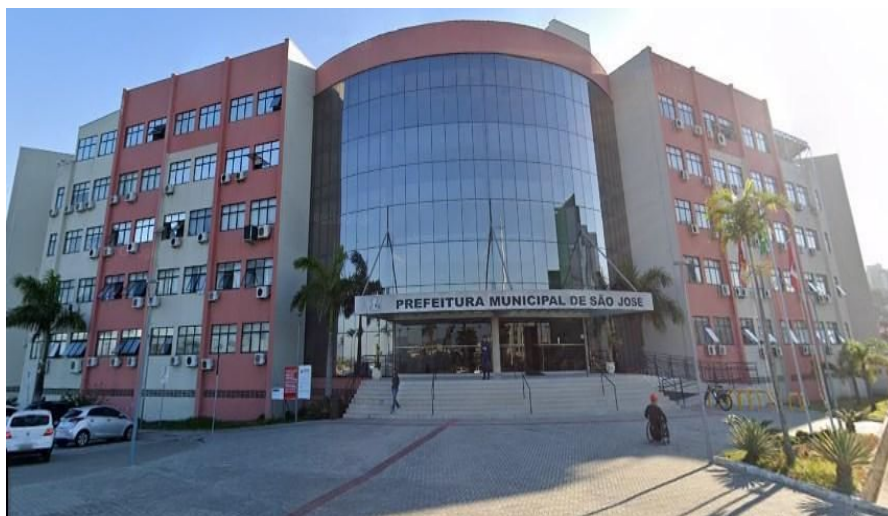
Figura 49 - Prédio da Prefeitura de São José
