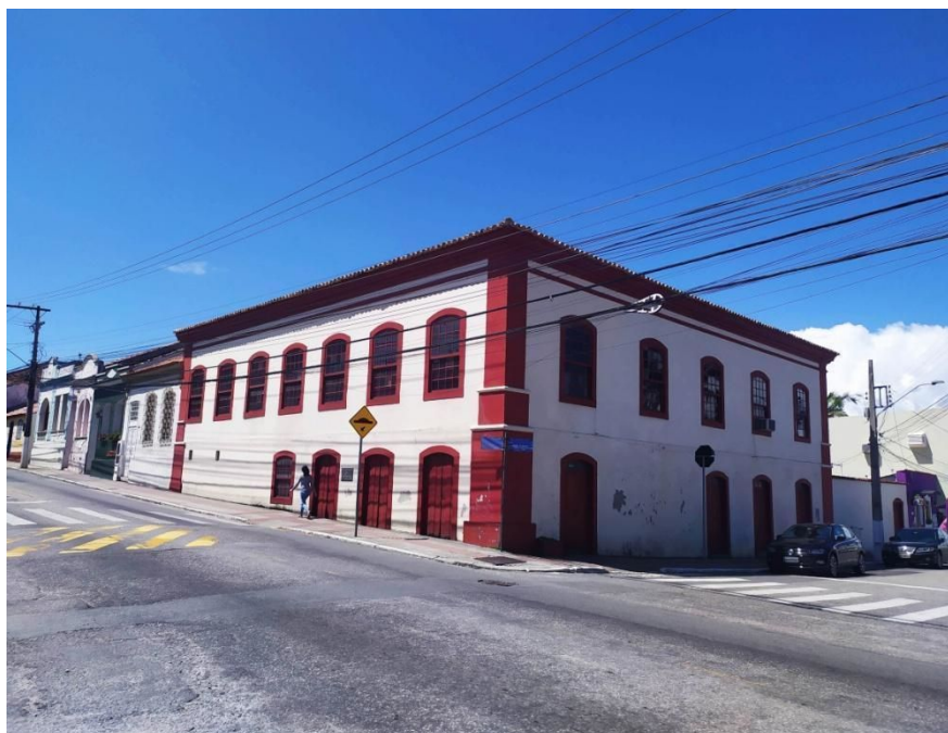
Figura 6 - Edificação tombada no Centro Histórico - Museu Municipal
