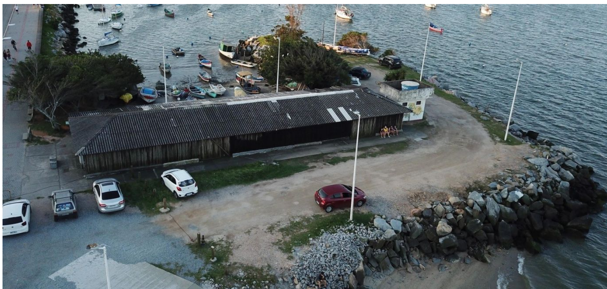
Figura 44 - Ranchos de pescadores no trecho 3 da orla
