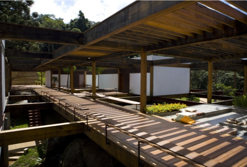
Casa Grelha. Forte, Gimenes & Marcondes Ferraz Arquitetos
