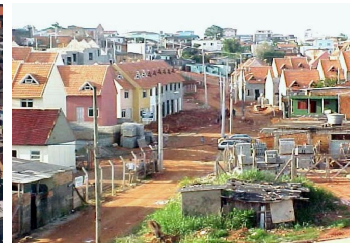
Comunidade durante as obras de urbanização.
