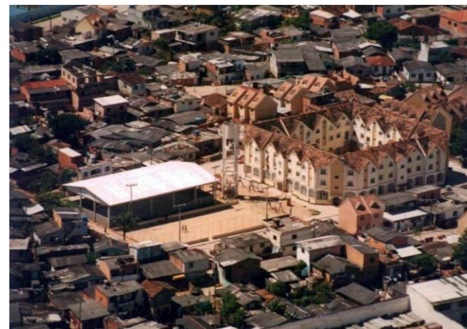
Comunidade no início das obras de urbanização.
