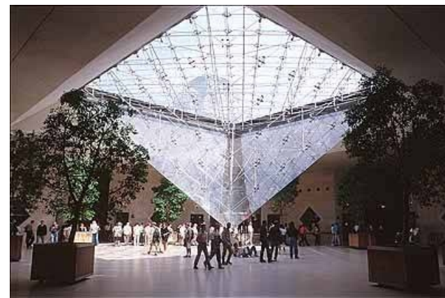
VISTA INTERNA INTERVENÇÃO MUSEU DO LOUVRE - PARIS. (FONTE: WWW.LOUVRE.FR)
