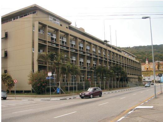
Prédio do Governo de Santa Catarina desativado. Fonte: Arquivo pessoal.
