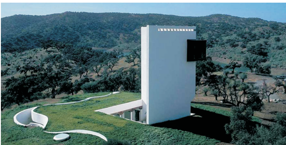
Casa de Retiro espiritual, 1975. Sevilla -Espanha.
