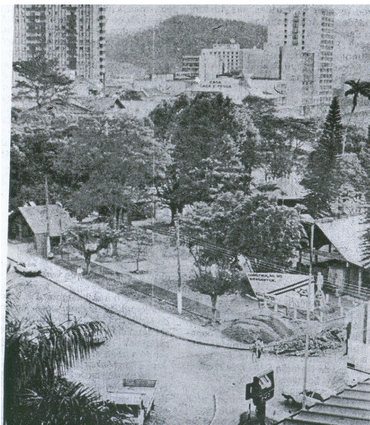
Figura 58: A Praça Hercílio Luz durante as obras de construção do Biergarten. Na parte da frente, o portal de entrada. Fonte: Jornal de Santa Catarina, 10/07/1987.
