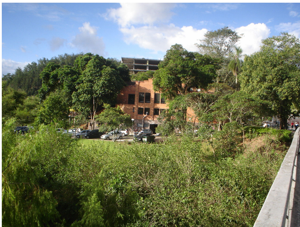
Figura 47: Praça Hercílio Luz atualmente, vista pelos fundos da mini-cervejaria, onde se localiza do estacionamento. Atrás, vê-se o Edifício América. Fonte: Acervo pessoal.
