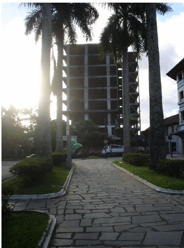
Figura 61: Edifício América, visto da Alameda Duque de Caxias. Fonte: Acervo pessoal.
