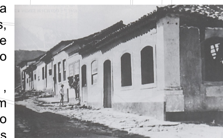
Construções simples, rua Nunes Machado, antiga Rua da Lapa. Fonte: Silva, 1999.
