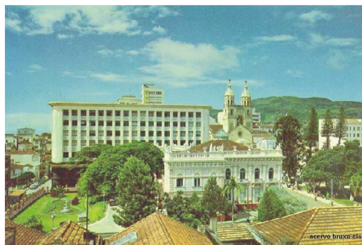
Palácio Cruz e Sousa na década de 70, quando ainda funcionava como sede de governo do Estado. Fonte: www.ufsc.br/~esilva
