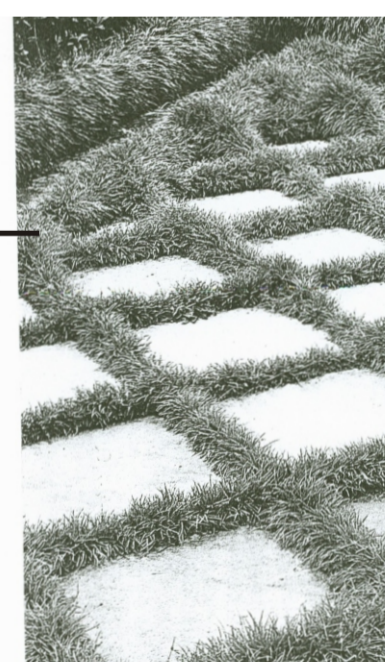
Piso de Concreto intertravado com grama. Este é o piso de dos estares sob pérgolas.
