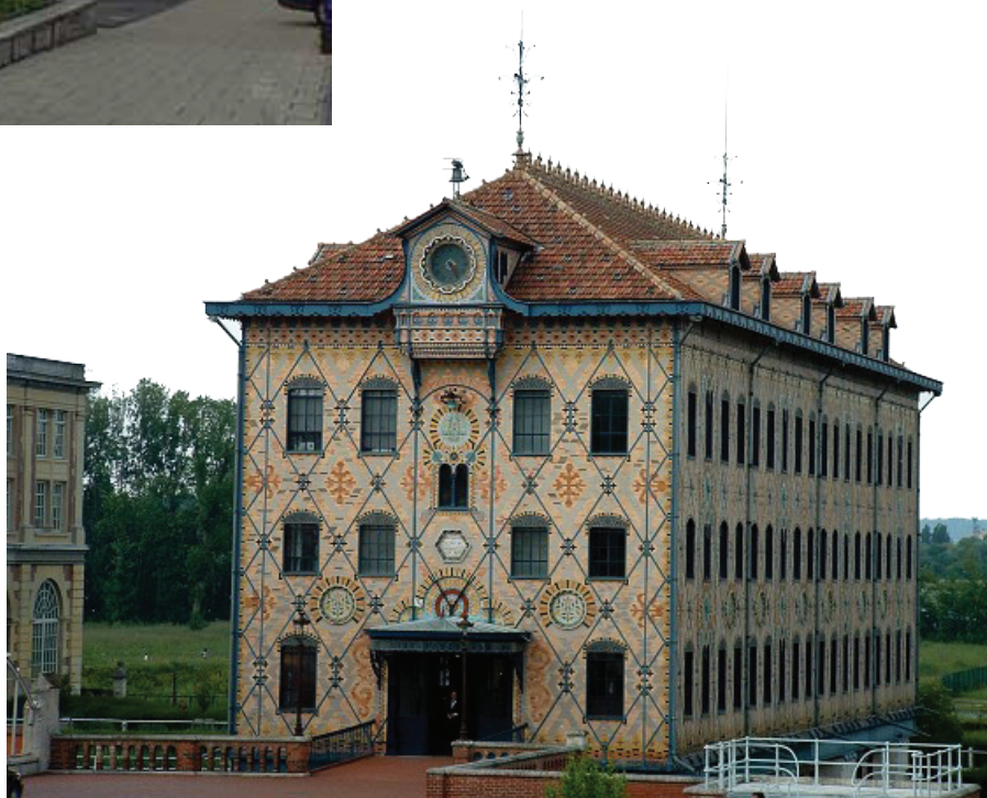
Fig. 5 | Fábrica de Chocolates Menier, projetada pelo arquiteto Jules Saulnier, em 1872 e a sua estrutura metálica aparente. Fonte: http://fr.structurae.de/photos/index.cfm?JS=22375
