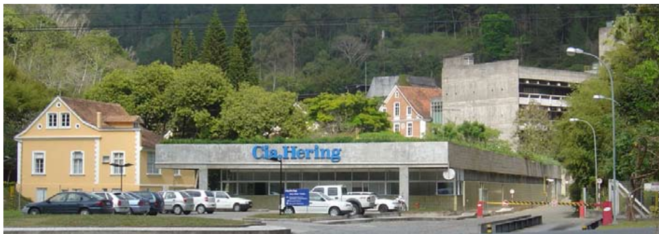
Fig. 9 | Fábrica Hering em Blumenau (SC), do arquiteto alemão Hans Broos. Fonte Acervo próprio.
