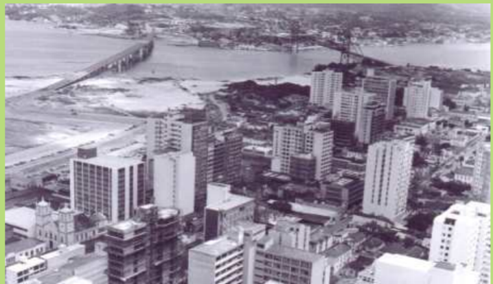
Construção Ponte Colombo Salles. Fonte: Casa da Memória
