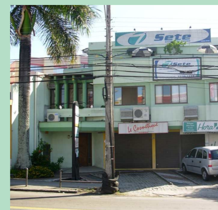
Exemplo de despoluição visual em uma edificação da Rua Lauro Linhares, foram retirados ar condicionados placas excessivas e a fiação aérea, que escondiam o prédio. Elaboração da autora.
