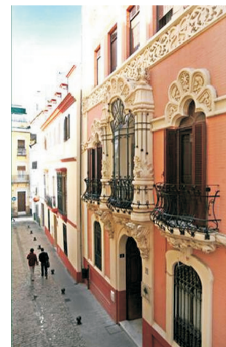
Residência Estudantil Santa Ana no Centro Histórico de Sevilha, Espanha Fonte: http://www.sta-ana.com/
