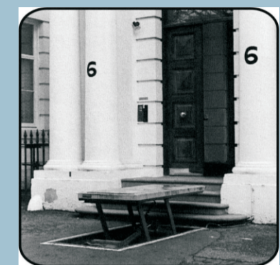
Elevador hidráulico para acesso de deficientes visuais em edificações históricas
