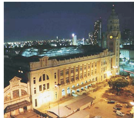
Exterior da Estação Júlio Prestes Fonte: Projeto & Design, 274.
