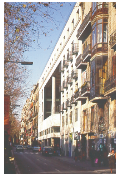
Inserção e edifícios vizinhos Fonte: MBM Arquitectes
