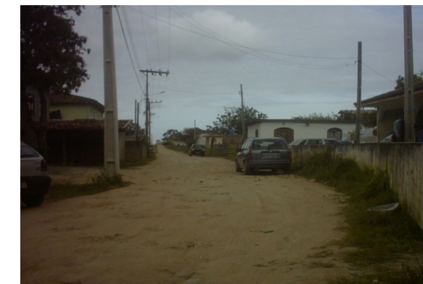
Falta de infraestrutura
