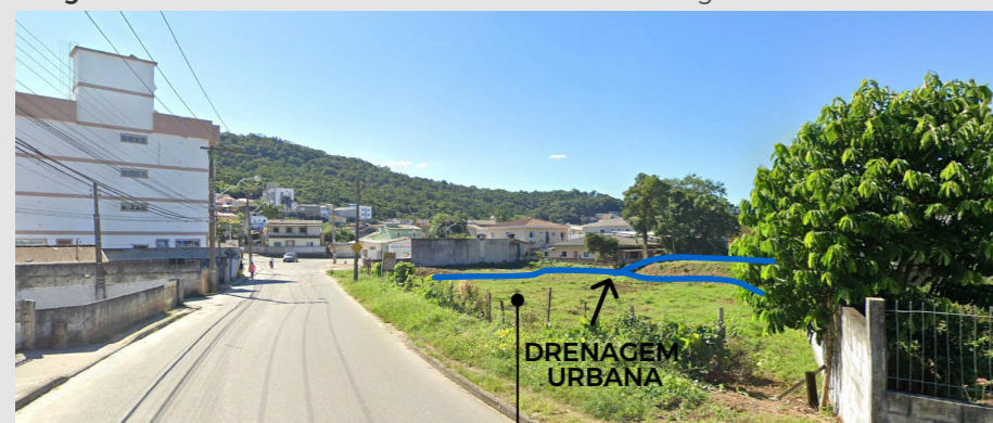
Figura 39 - Rua Homero de Miranda Gomes e drenagem urbana do bairro
