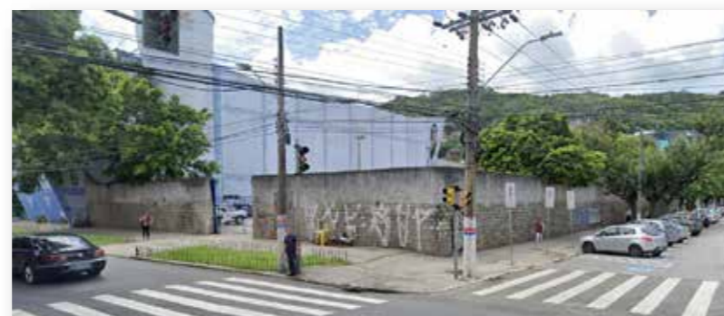
FIGURA 9. Esquina Av. Hercílio Luz com Rua Bulcão Viana. Foto: Google Maps, 2021.
