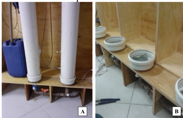
Figura 20 – Detalhes construtivos da interligação entre as colunas do piloto. a) detalhe das conexões na interligação entre as colunas; b) detalhes da base em cada coluna com os caps de 150mm.
