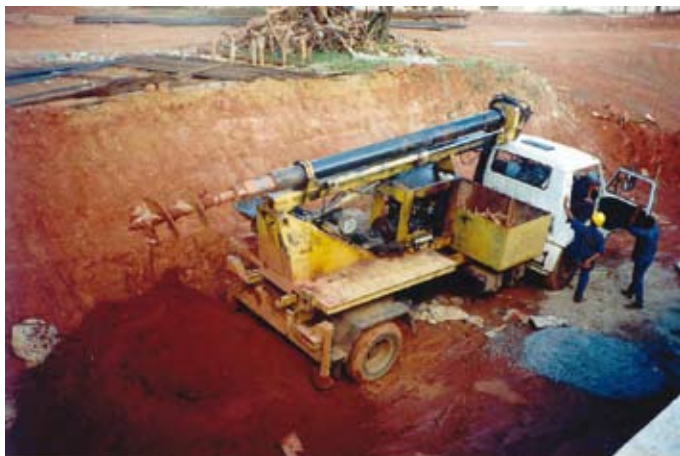
Figura 12 – Perfuração de solo para a execução de uma estaca de fundação
