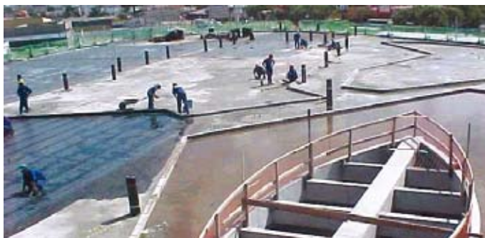
Figura 19 – Cobertura de edifício. Impermeabilização da laje para instalação de espelhos d'água e jardins
