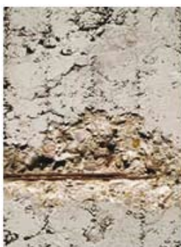
Figura 22 – Broca ou bicheira em elemento de concreto
