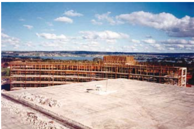
Figura 18 – Detalhe da cobertura de uma construção
