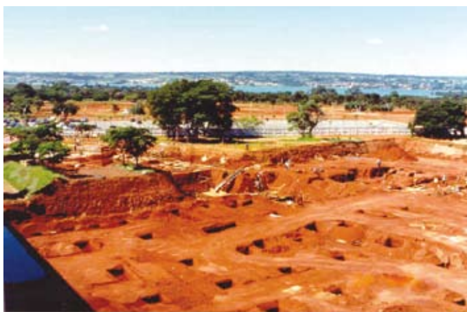
Figura 7 – Vista da locação de uma obra pública
