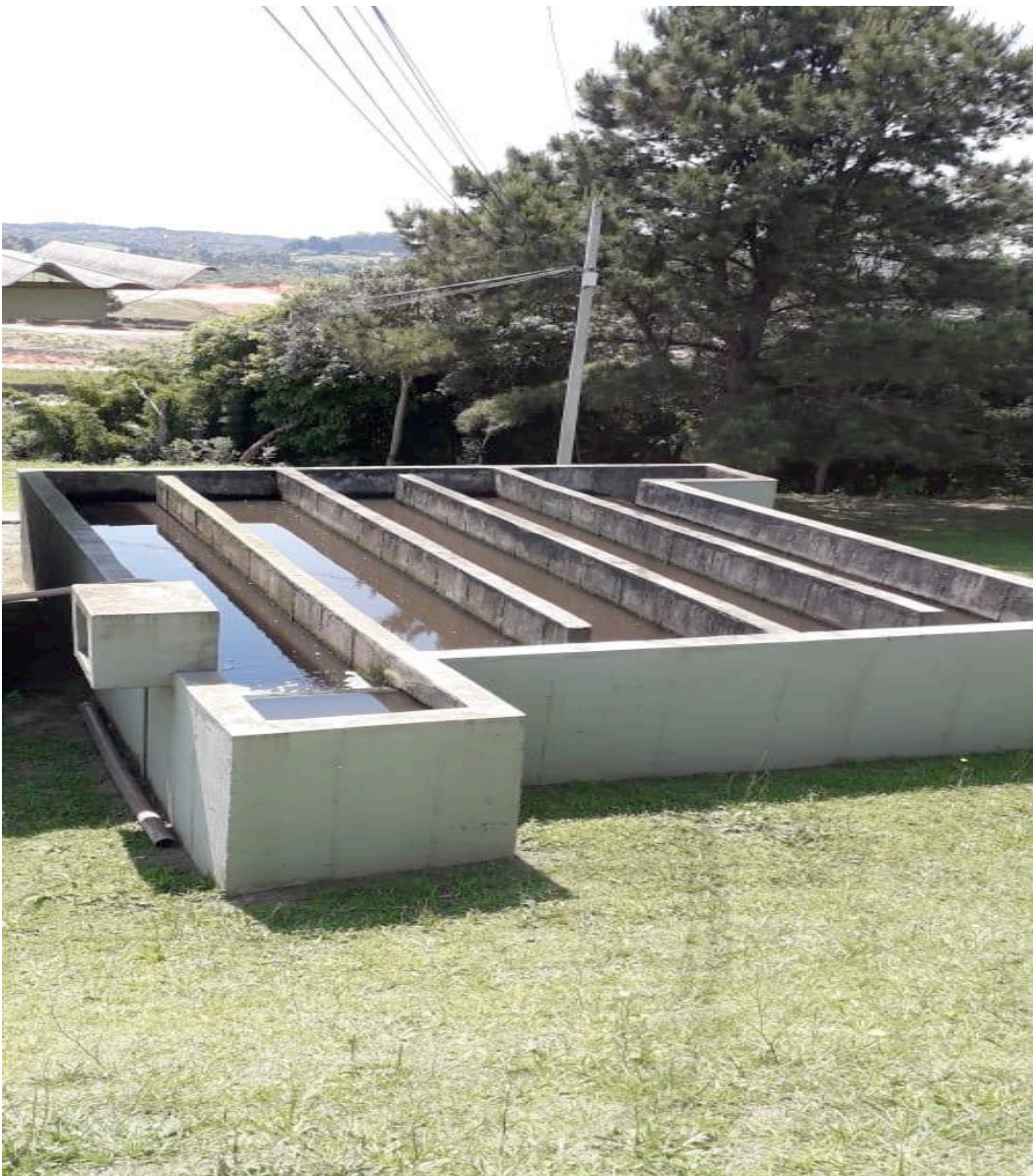
Visita ao Esgoto Sanitário em Rio Negrinho-SC. Fonte: Elaborada pela autora 2019.
