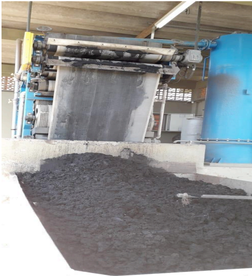
Visita ao Esgoto Sanitário em Rio Negrinho-SC. Fonte: Elaborada pela autora 2019.
