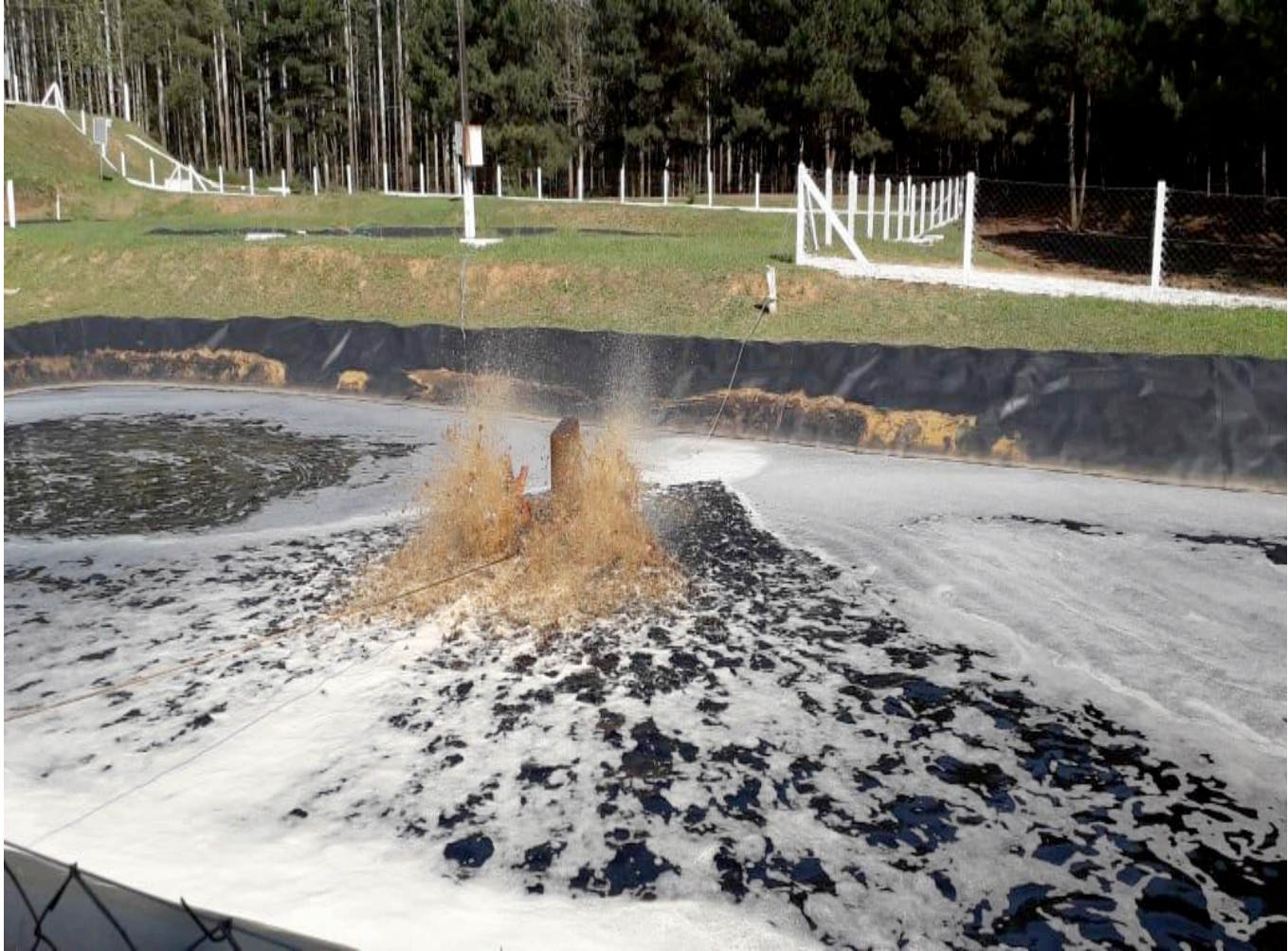
Visita ao Aterro Sanitário em Rio Negrinho-SC. Fonte:Elaborada pela autora. 2019.
