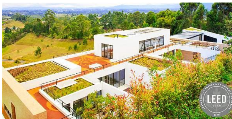
Figura 5: Residência Casa Rionegro, Colômbia. Fonte: USGBC Casa FENIX Rionegro (2015)
