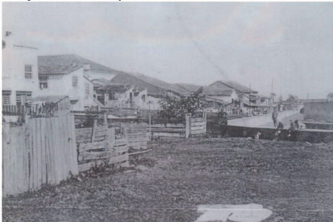
Figura 6: Beco Irmão Joaquim com o Rio da Bulha canalizado, década de 10.
