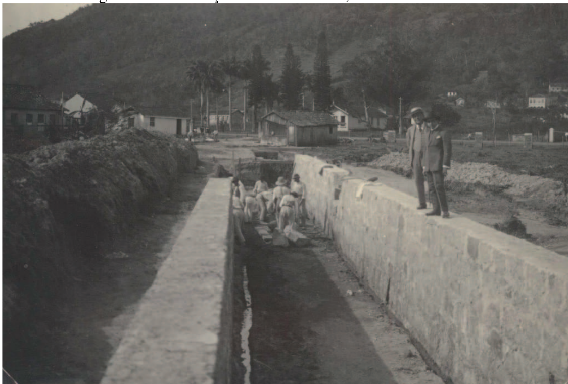
Figura 12: Canalização do Rio da Bulha, início do século XX.
