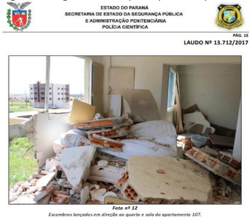
Figura 11. Imagens de uma explosão provocada por GLP
