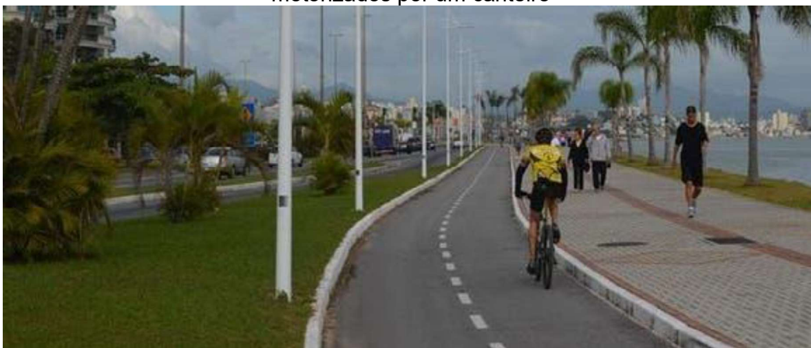
Figura 32-Exemplo de ciclovia, separada fisicamente da via para automóveis motorizados por um canteiro
