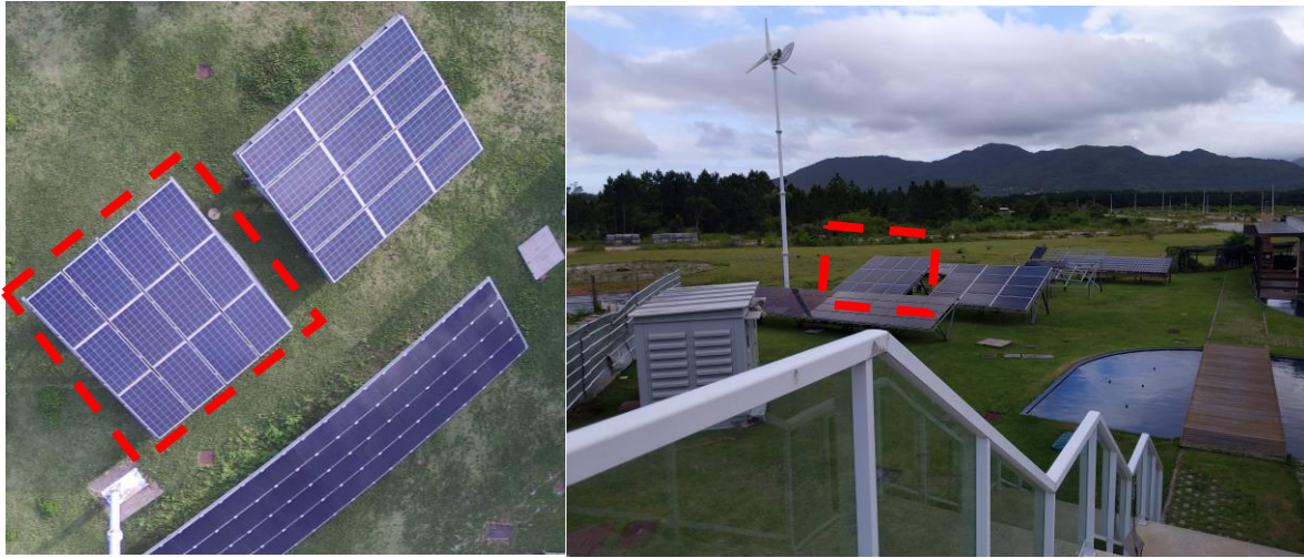
Figura 1. Imagens do sistema FV de 2 kW escolhido para a instalação da bateria no laboratório Fotovoltaica-UFSC. Fonte: elaborado pelos autores.
