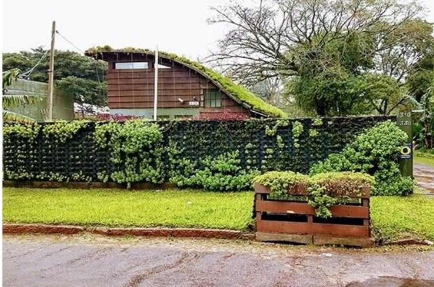
Figura 3: Muro vegetado com barreira acústica recém instalado. Foto: Ecotelhado.
