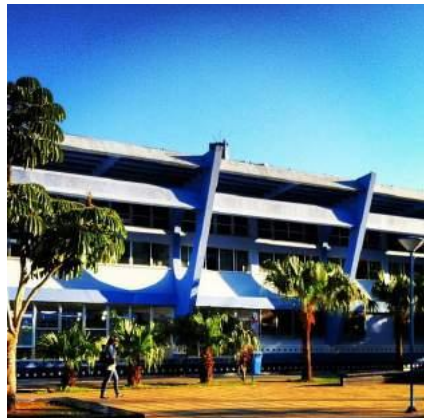
IEE na Av. Hercílio Luz Fonte: Foursquare Foto: Jefferson F., 2013
