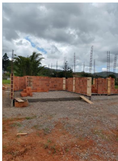
(b) Assentamento de alven
