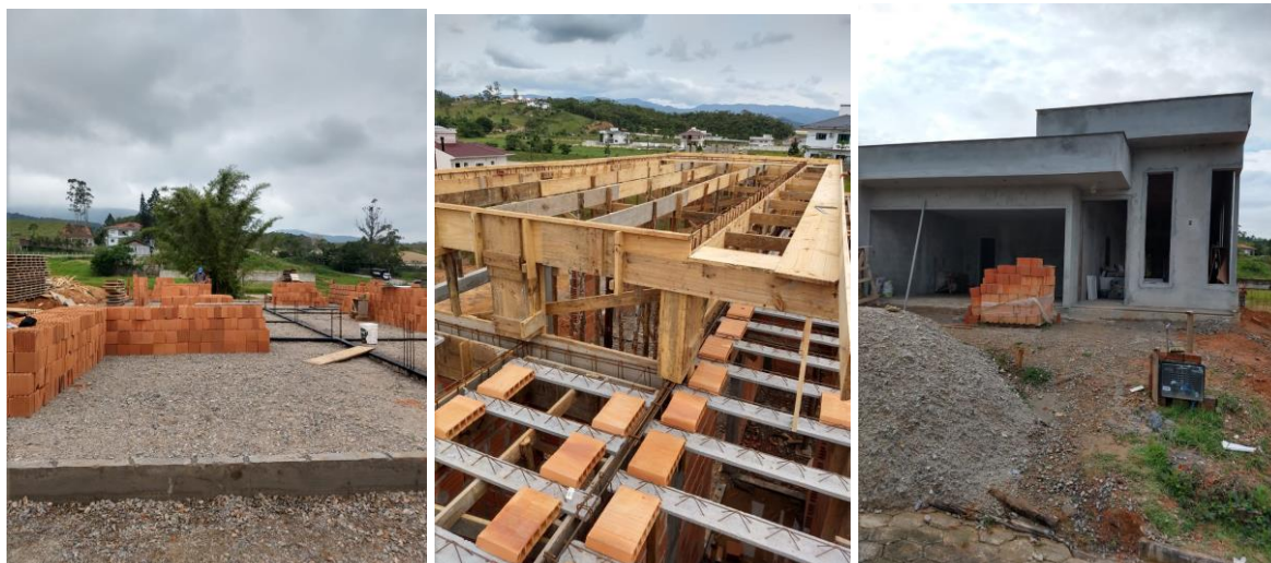
Figura 15 - Acompanhamento da obra
