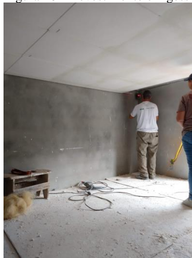
Figura 26 – Revestimento em gesso
