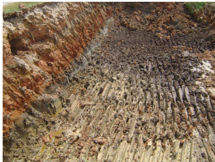
Figura 40 – Solo argiloso encontrado durante a escavação para a obra de construção do acesso.
