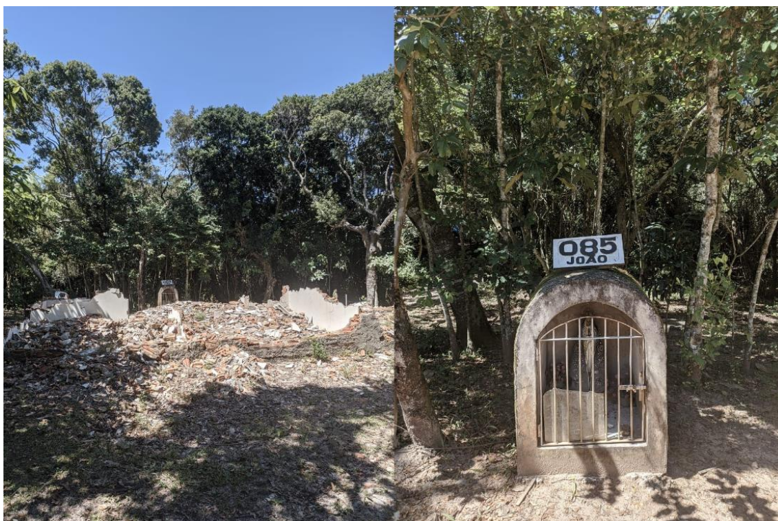
Figura 247 - Escombros de uma casa demolida em Naufragados. Fonte: acervo da autora.
