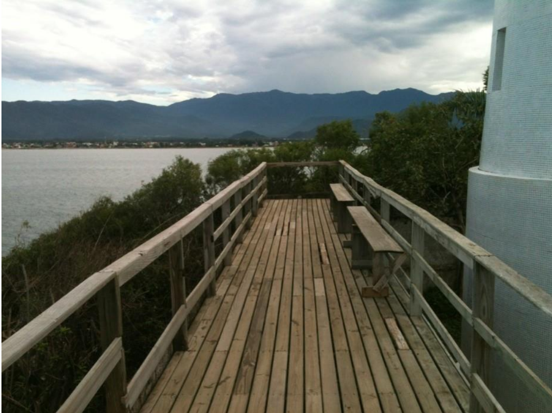
Figura 16 – Deck/mirante existente no Farol de Naufragados.
