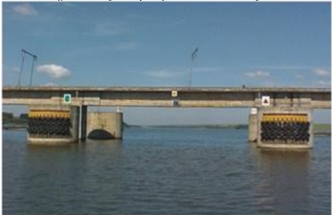
Figura 3 – Dolphins de proteção de concreto com defensas
