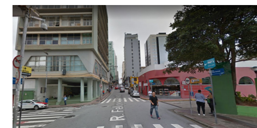
Edificação em pilotis já existente. Fonte: Google Street View
