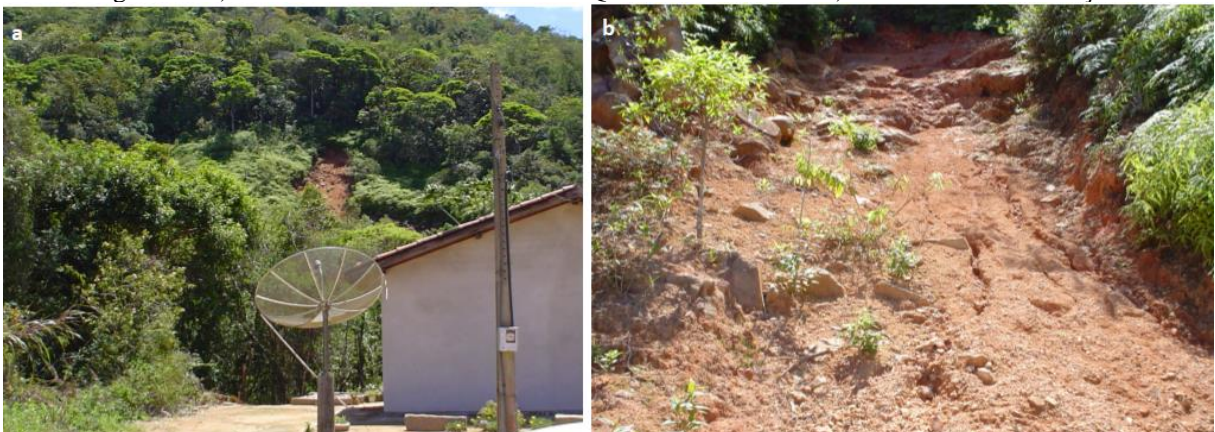
Figura 18: a) Instabilidade de talude no bairro Quilômetro Sessenta. b) Detalhe da instabilização.
