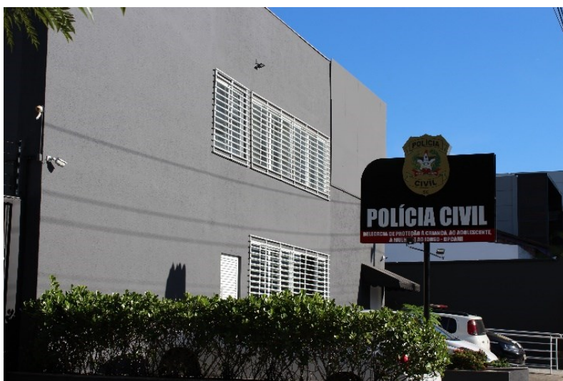
Figura 45: Novas instalações da DPCAMI 01 Fonte: autora (2021)
