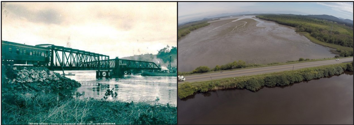
Figura 15 – Comparativo da Ponte Ferroviária sobre o Canal do Linguado.
