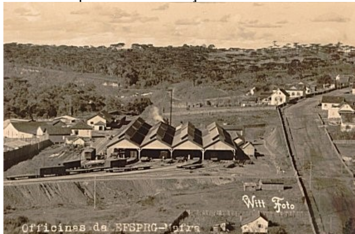
Figura 37 - Galpão de Manutenções de EFSPRG em Mafra.
