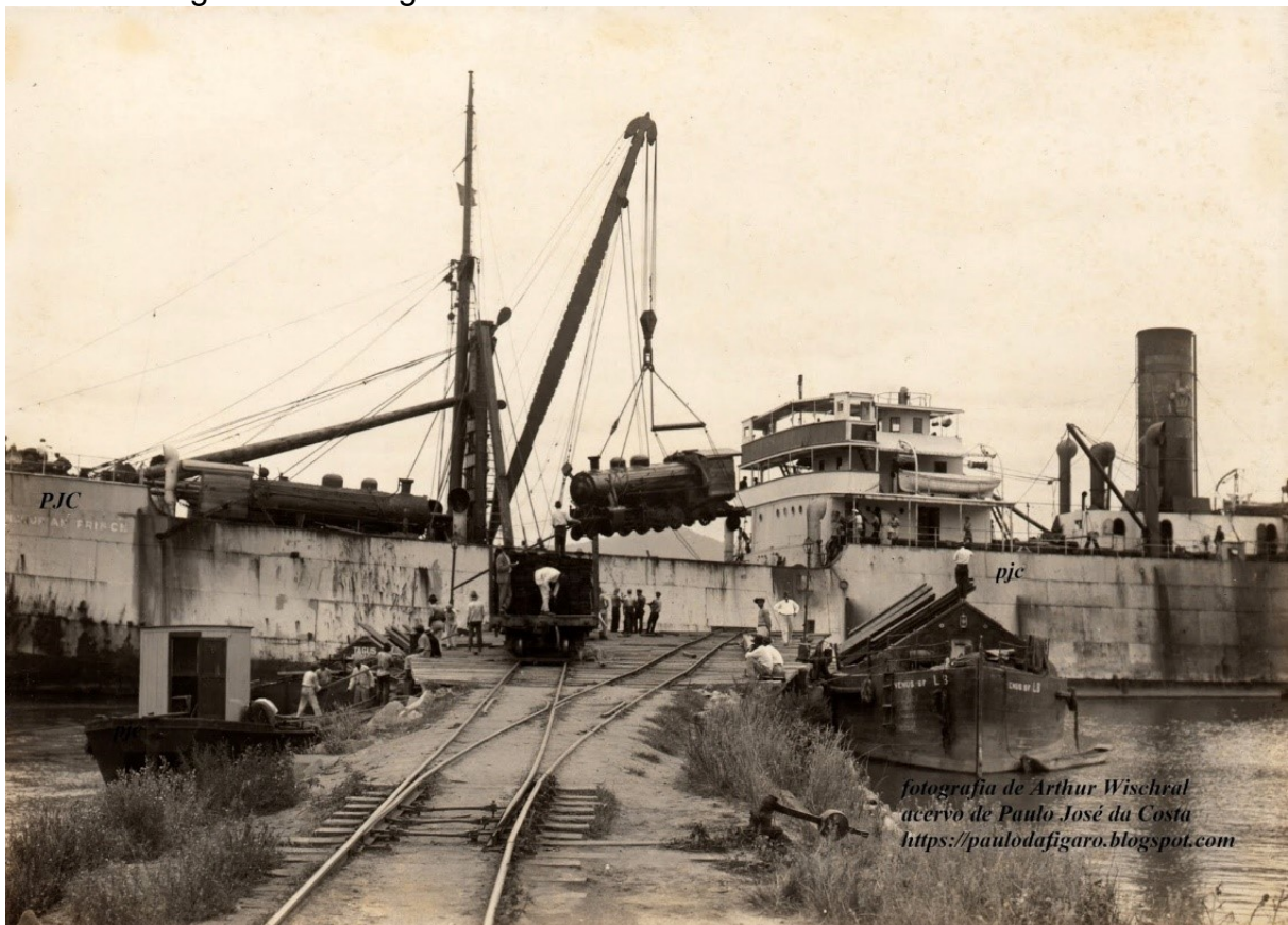
Figura 06 - Chegada de locomotivas da Baldwin Locomotive Co.
