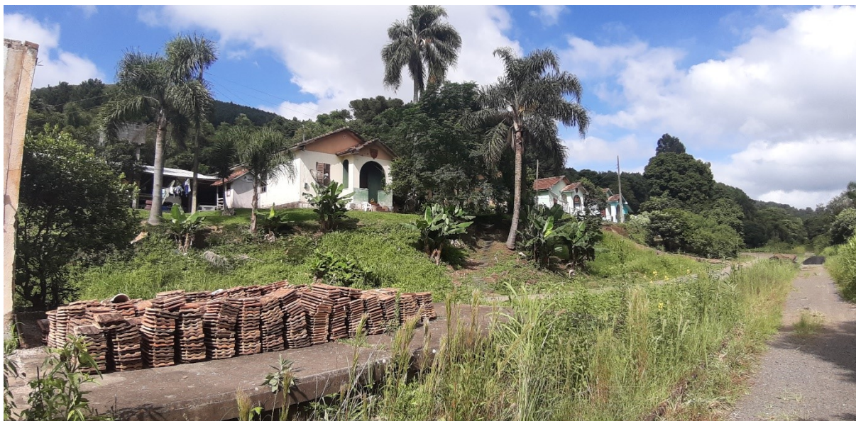
Figura 48 - Vila dos Ferroviários na Estação Lança.
