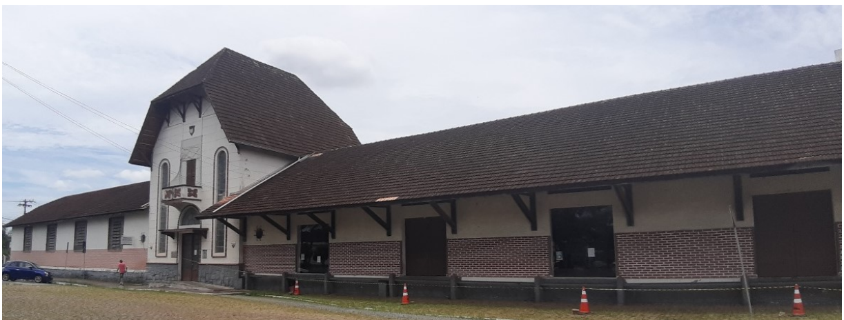
Figura 18 – Terminal de Cargas da Estação Ferroviária Joinville.
